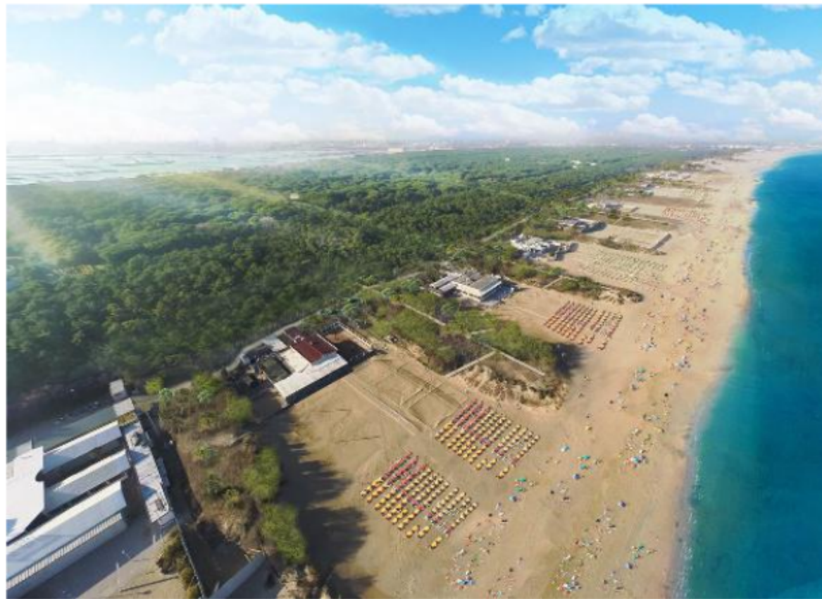
A sinistra i lavori alla presenza del sindaco Michele de Pascale. Sopra ecco come sarà la spiaggia con le dune unite alla pineta
